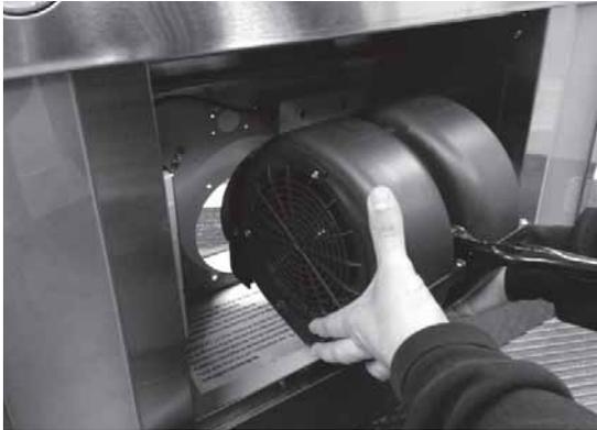
1. Placez le ventilateur interne dans le boîtier de la hotte de façon à ce que le collier du ventilateur dépasse de 6" de la bride circulaire de l'ouverture.
