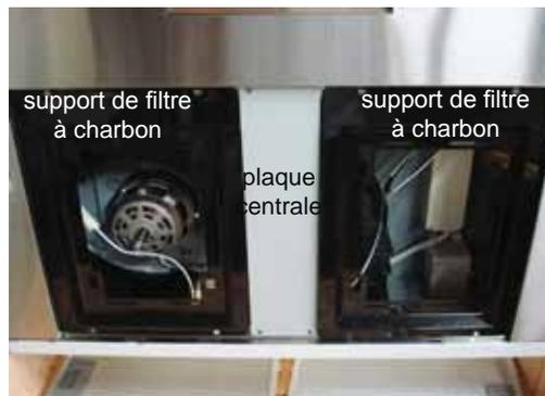
2. En utilisant les éléments du ZRC-0200, installez (2) supports de filtre à charbon et la plaque centrale au bas de la hotte à l'aide de (4) vis pour chaque élément. Les vis sont préinstallées. Enlevez-les avant d'installer les supports et la plaque centrale. Remettez les vis en place.
